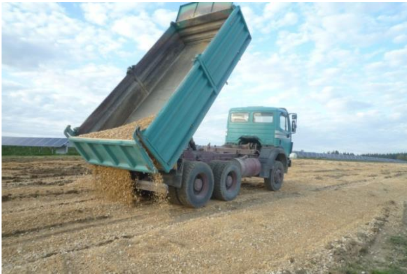
Abb.2: Fertige Kalkmischung (Kalkschotter) von 0,1-60mm.
