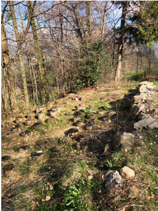
Abb. 15: Eingegrabenes Rundholz am Waldrand (4. April 2023)
